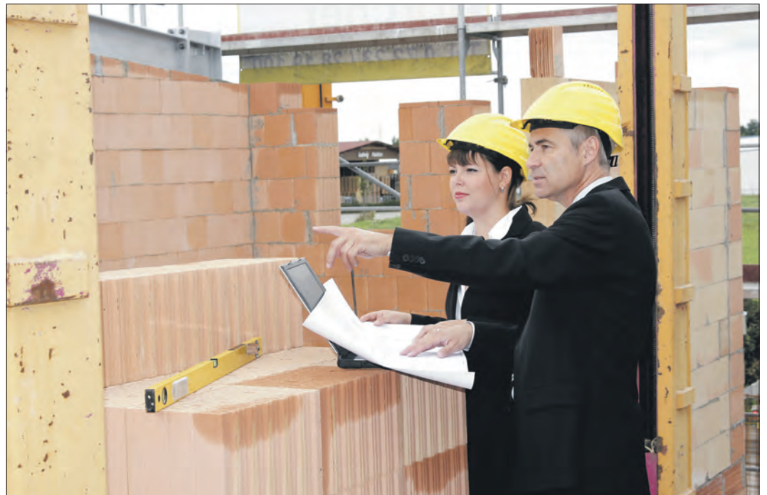
(pb) Seriöse Bauträger zeichnen sich in allen Planungs- und Bauphasen in der Regel durch Transparenz und Verhandlungsbereitschaft aus. Foto: LBS West
