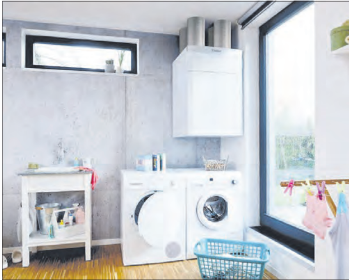
Von Waschmaschine, Trockner & Co. produzierte Luftfeuchtigkeit bietet Schimmelpilz bei nicht ausreichender Lüftung idealen Nährboden.
